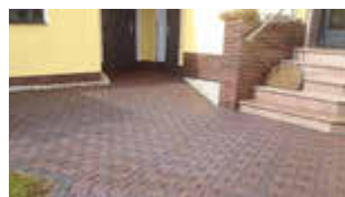
... und nach unserer Steinsanierung
