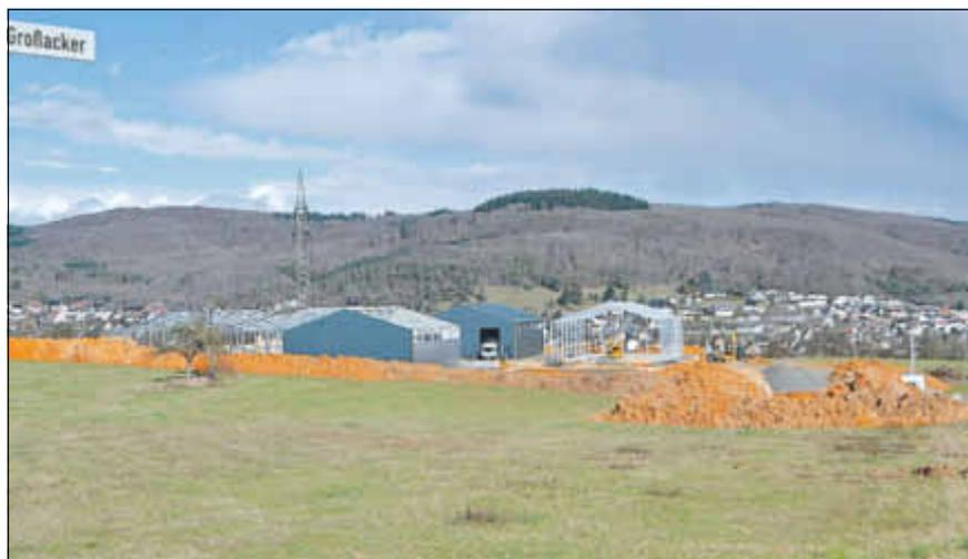
Sie sollen bis September 2021 fertig gestellt werden. Es handelt sich jeweils um freistehende, auf die Fundamentanker aufgeschraubte Zweigelenkrahmenkonstruktion, einschließlich Giebelbinder, Dach- und Windverbände. Die Dachneigung beträgt 15 - 18 Grad.
